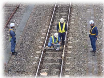
全線軌道検測工事
