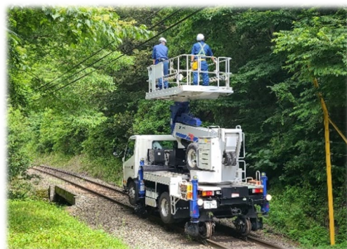
支障木伐採（軌陸高所作業車使用）
