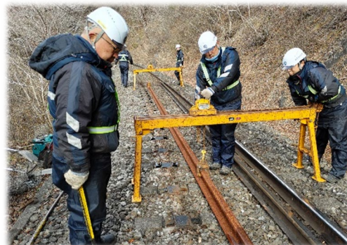
レール交換(日頃市線 1k650m 付近)
