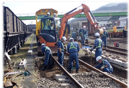
盛駅構内 P C まくらぎ化工事
