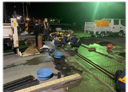
中井街道踏切改良工事（夜間作業）
