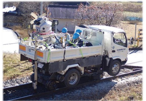
鉄道MMS計測工事（軌陸車使用）
