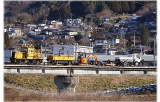
盛川橋梁道床交換・合成まくらぎ化工事 (提供写真)
