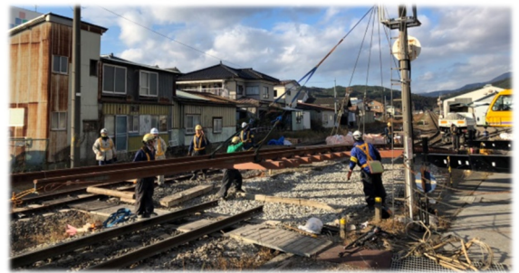
盛駅構内 37 号ポイント改良工事
