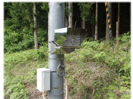
線路敷地内獣類侵入防止対策（鹿） U-SONIC(ユーソニック)設置
